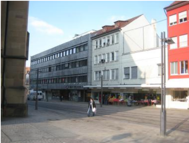
Forderseite der Gebäude
