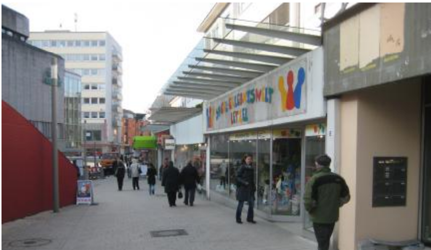
Forderseite der Gebäude
